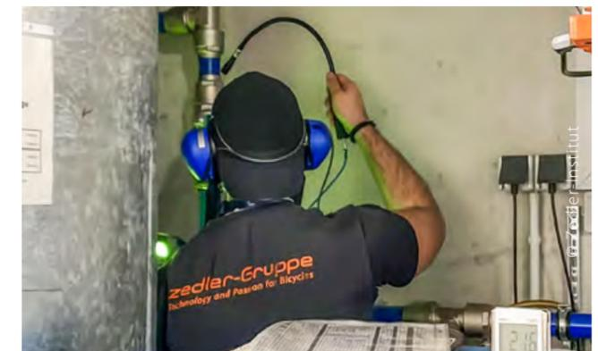
Kevin Togonal bei der Prüfung eventueller Leckagen des Druckluftnetzes
