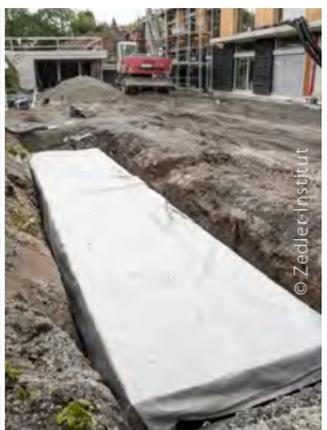
**Rigolen** zur langsamen Versickerung des Regenwassers
