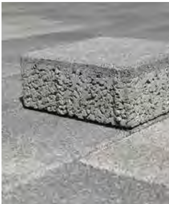
Versickerung auf der gesamten Hof- und Parkfläche
