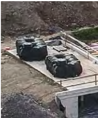
Regenwasserzisterne (zweimal 5.000 l) vor dem Einbau
